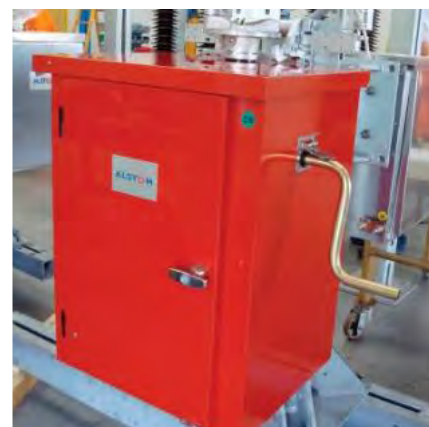
Пофарбована шафа приводу для додаткового захисту від корозії
