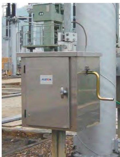
Шафа моторизованого приводу типу CMM
