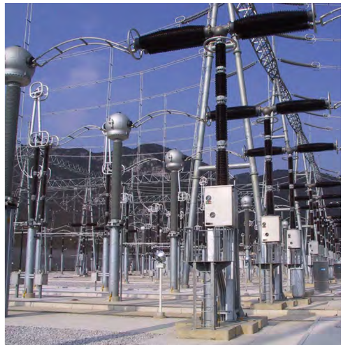
Вимикачі з конденсаторами та захисними екранами
